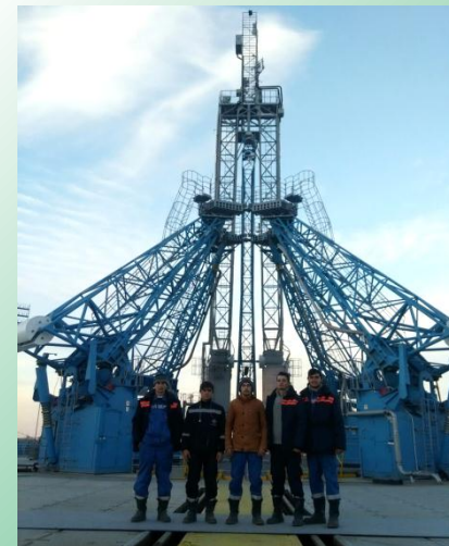
Студенты МГТУ на строительстве космодрома «Восточный»
